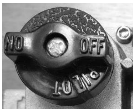
Рисунок 9 – Ручка блока регулятора газовой горелки.
