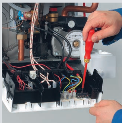
3 Подключение электропитания
